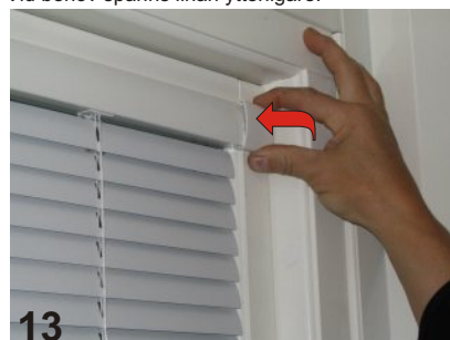
13 Täckåporna monteras över persiennfästen. Börja i underkant med låshaken i spåret, vik upp och knäpp fast täckåpan i överkant.
