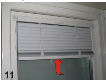
11 När rätt spänning erhålls tillslut låslocket. Kontrollera att persiennen/plissén stannar i önskat läge när den förs upp och/eller nedåt. Vid behov spänns lina ytterligare.
