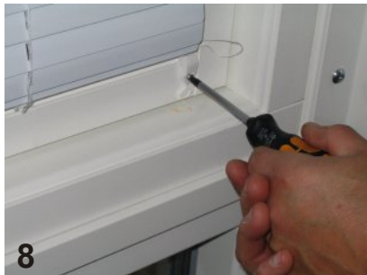
8 Skruva för hand fast de båda linfästena med de medföljande skruvarna.
