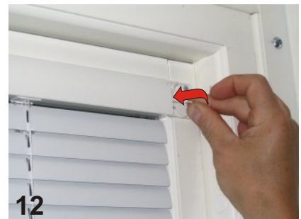
12 Klipp av överbliven lina på båda sidor 20cm från överlist. För att gömma den resterande lina trä den igenom hålet enl. bild.
