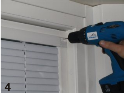
4 Tryck fast persiennen/plissén mot glasöppningens överkant. Förborra för två skruvar varje sida enl. bild. Vid persienn med 4 linor skall stödskruv monteras enl medföljande instruktion. Kassetten hängs på stödskraven och montering sker sedan lika ovan. Stödskruv och instruktion finns i påse i överlisten.
