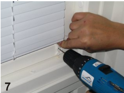
7 Förborra för en skruv i varje fäste.
